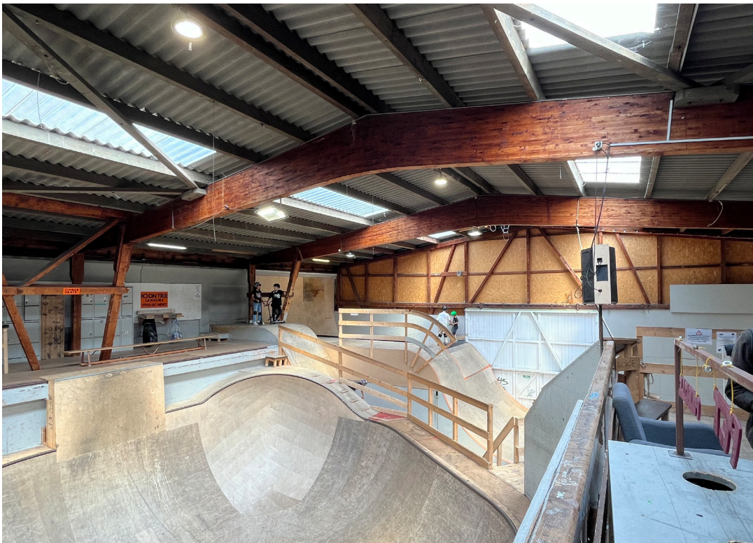
30 Poutres bananes du dépôt de 1961 (AJ 2024).
